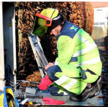
Die Stuttgart Netze will durch den Einbau von Messtechnik in Kabelverteilerschränken Stromausfällen schneller auf die Schliche kommen. Das Bild zeigt einen Betriebsmonteur beim Einbau der Messtechnik. (Foto: Stuttgart Netze)
