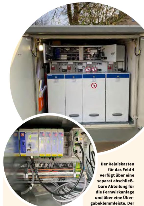
Ormazabal hat für die erste fernsteuerbare Ortsnetzstation im Netz von Westfalen Weser eine Pilot-Mittelspannungsschaltanlage geliefert. Ihre Sekundärtechnik wurde projektindividuell konfiguriert. (Foto: Westfalen Weser Netz GmbH)
