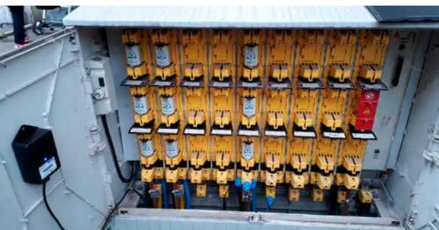
Ein Sensor BPL-Modem in einem Mainzer Verteilerkasten übermittelt aktuelle Netz Zustandsdaten. (Foto: PPC AG)
