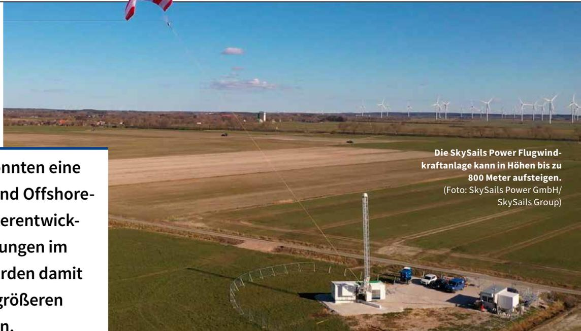
Die SkySails Power Flugwindkraftanlage kann in Höhen bis zu 800 Meter aufsteigen.
