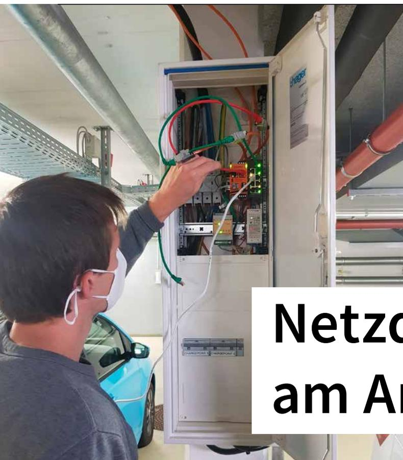
Bei gemeinsamen Tests mit den SWM wurde ein Rundsteuersignal an den Empfänger gesendet und die verfügbare Leistung am Münchner Standort des Technologieunternehmens nach kurzer Zeit entsprechend angepasst.
