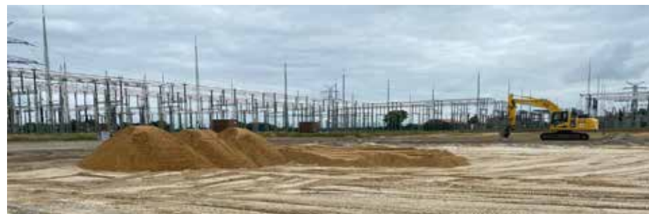
In Wilster wurde mit ersten bauvorbereitenden Maßnahmen für die Errichtung der SuedLink-Konverterstation begonnen. (Foto: TenneT TSO GmbH)
