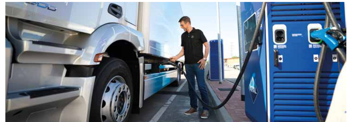
Aral eröffnet die erste Ladestation für elektrische Lkw in Rheinland-Pfalz innerhalb des bp Konzerns. (Foto: Aral AG)
