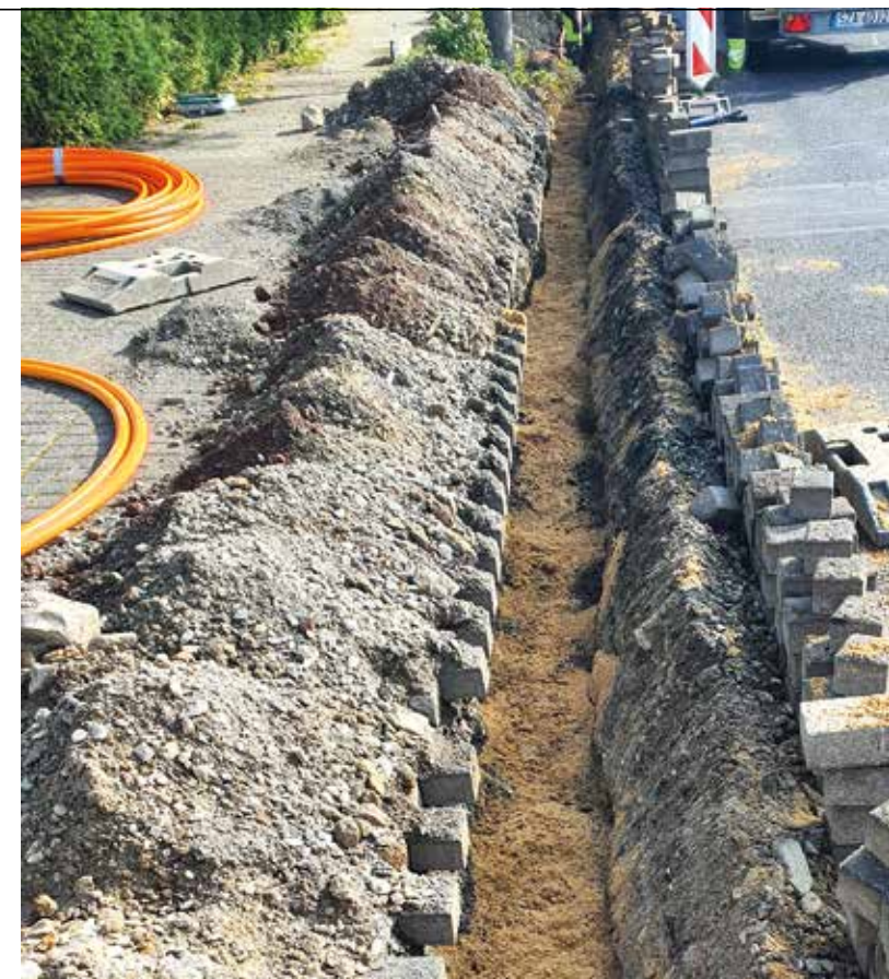
Beispiele zeigen, dass der Netzausbau bei guter Vorbereitung sogar ohne Fördermittel gestartet werden kann. (Foto: tktVivax GmbH)
